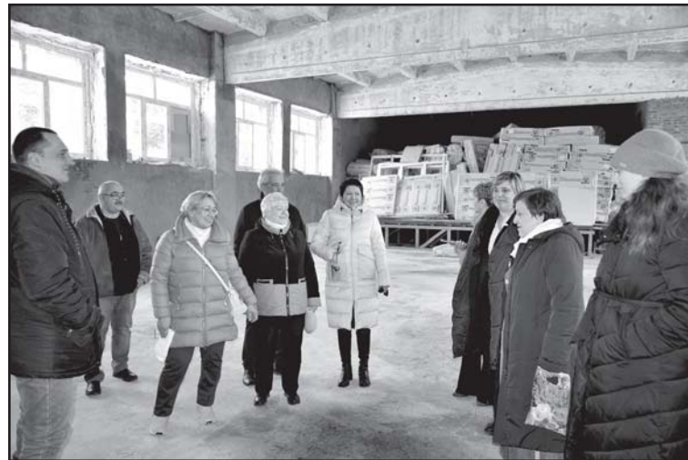
В актовом зале СОШ №2 работы идут полным ходом
